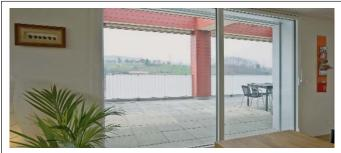
Die TOP-WIN Plus Fenster von 1a hunkeler sind im Passivhaus am richtigen Platz. Der 66 mm dicke Rahmen und der 80 mm dicke Flügel erlauben den Einbau von 3-fach Glas und eine stabile Befestigung der Beschläge. Trotzdem ist die Flügelansicht mit 58 mm genau so schlank, wie auch die Mittelpartie mit 92 mm. Das TOP-WIN Fenster lässt sich leibungsbündig einbauen. Ausserdem verfügt das System über drei Dichtungsebenen und erfüllt problemlos die Standards des Schweizer Passivhaus Labels Minergie-P.
