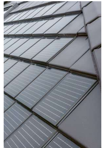
2 Solarziegel mit Blindmodulen zur optimalen Anpassung an den Dachrand.
