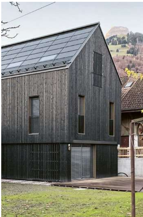
3 Ganzflächige «Indach»-Solaranlage.
