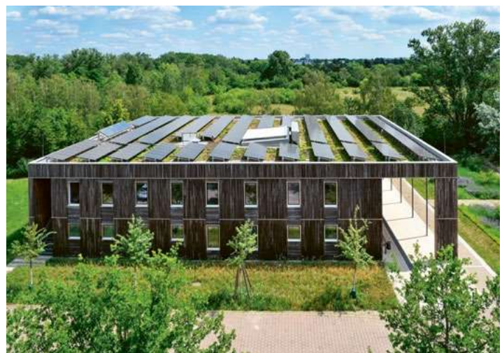
4 Solaranlage auf extensiv begrüntem Flachdach.
