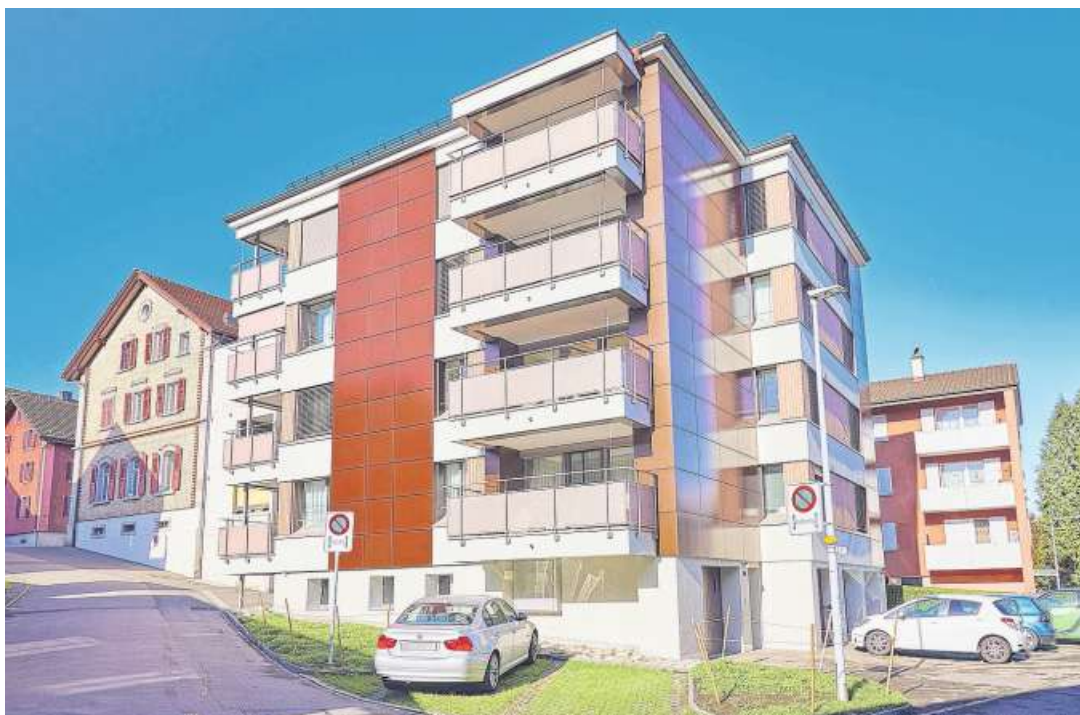
Unauffällig: Die braunen Flächen links und rechts der Balkone sind Photovoltaik-Panels.
